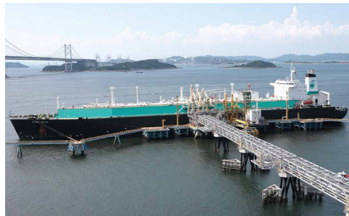
LNG importing facility (Sakaide LNG Company)
