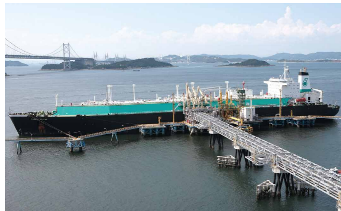
LNG importing facility (Sakaide LNG Company)
