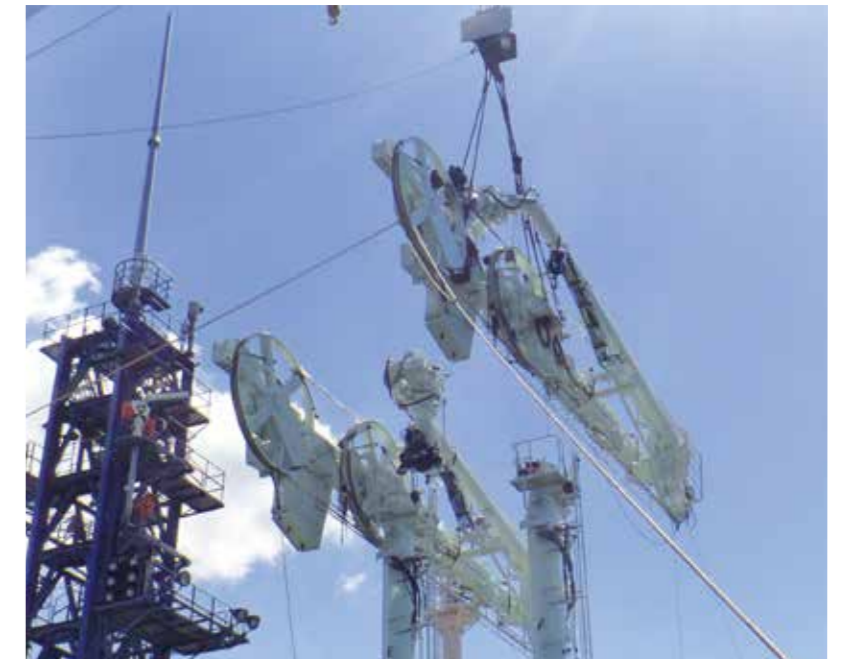
現地据付(海上クレーン使用)
