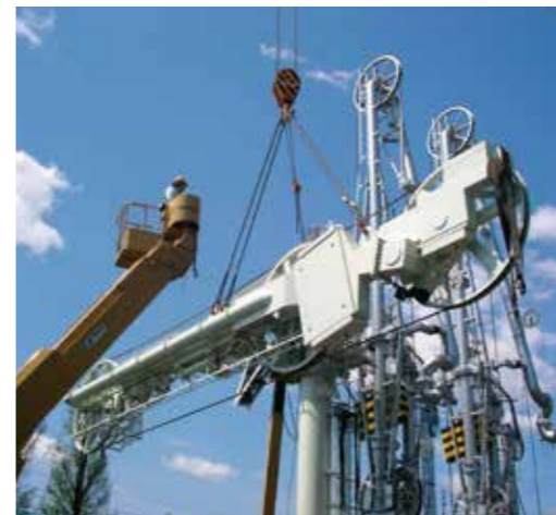
現地据付(陸上クレーン使用)
