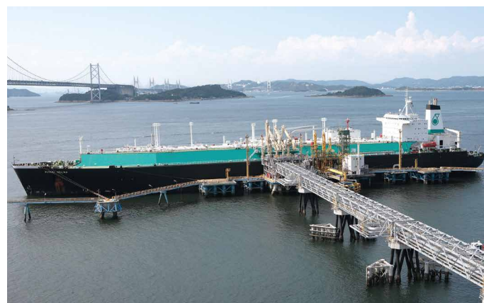
LNG importing facility (Sakaide LNG Company)
