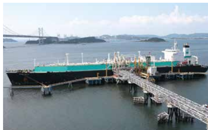
LNG importing facility (Sakaide LNG Company)
