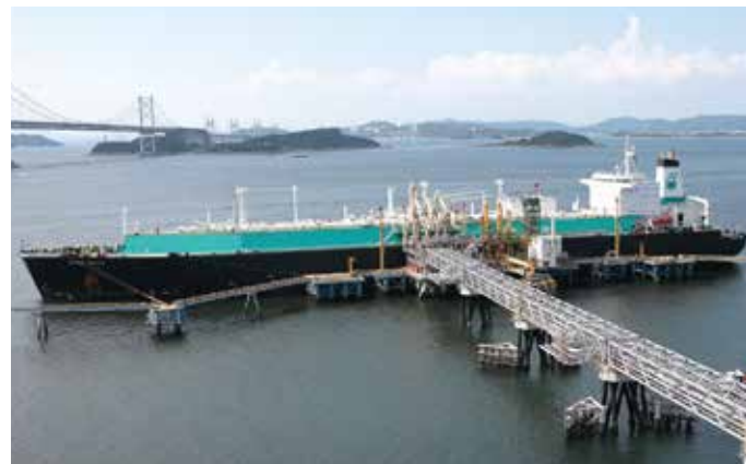
LNG importing facility (Sakaide LNG Company)
